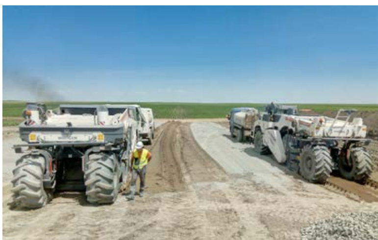
замешавање тла и хидрауличног везива
